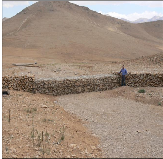
السدود الغايبونية: منشأة داخل المجرى توقف السيل لفترة مع الرسوبيات
